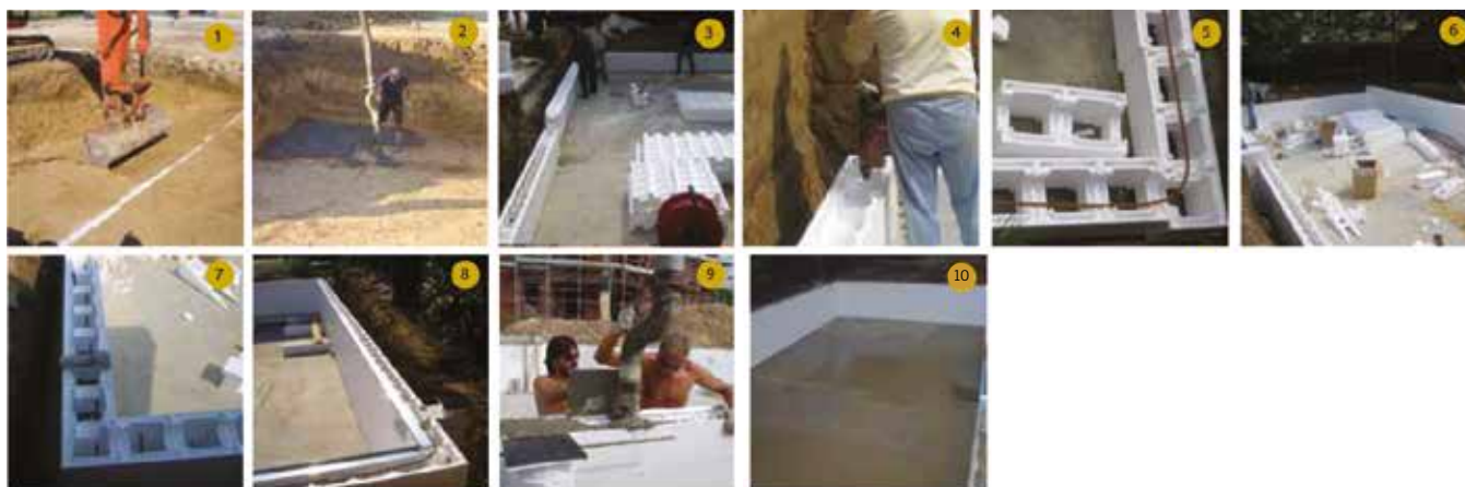
Immagini indicative delle fasi costruttive di una piscina con casseri in polistirolo (fasi da 1 a 10 in ordine cronologico).
